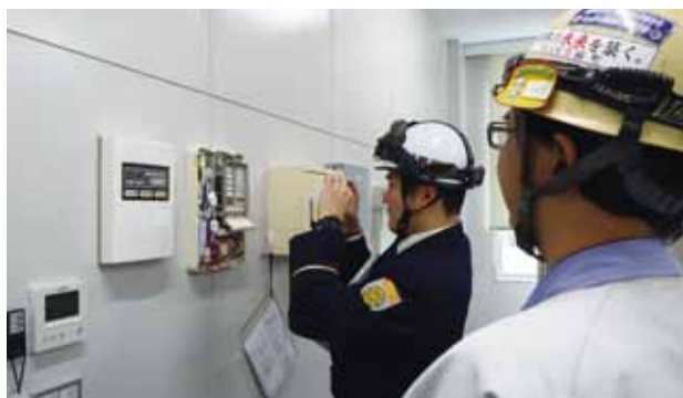
消防検査状況
