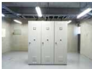
送水ポンプ盤更新
