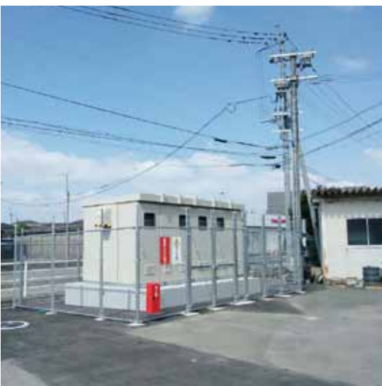
高圧受変電設備更新
